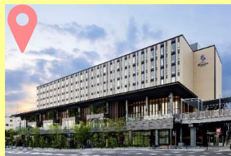
京都市中央卸売市場第一市場 「賑わいゾーン」活用事業（ホテル・商業施設） （京都府京都市）
