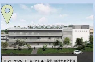
三浦市市民交流拠点整備事業 (三浦市市庁舎、庁舎付属棟、神奈川県保健センター) 2026年11月竣工予定 (神奈川県三浦市)
