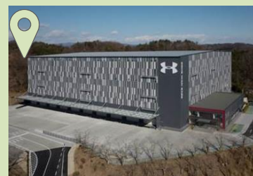
免震構造による大型物流倉庫建築工事 (福島県いわき市)
